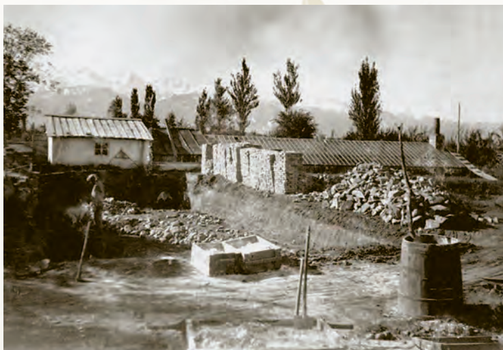
Строительство оранжереи (1936 г.)
